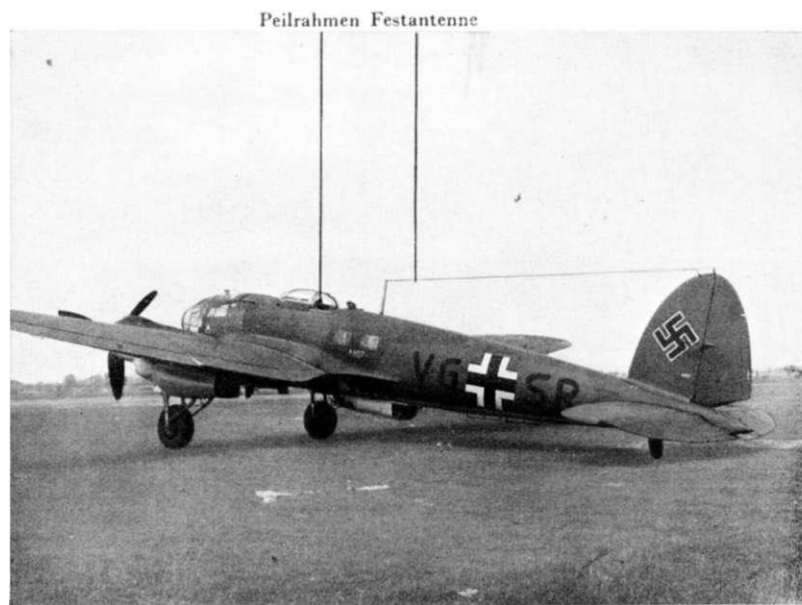
Abb. 21: Festantennen-Anlage und Peilrahmen auf dem Flugzeug
